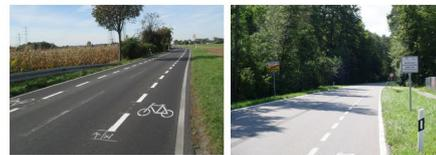
links: Fahrbahn mit markierten Schutzstreifen außerorts; rechts: Teststrecke des Forschungsprojektes zu Schutzstreifen außerorts in Alton-Blankenhofen (Foto: VIA)
